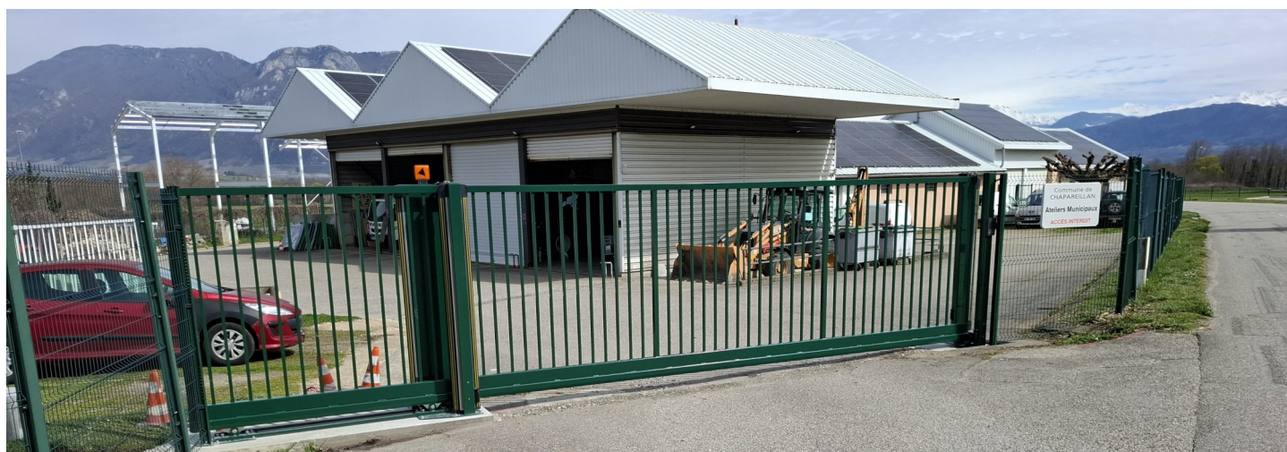
Nouveau portail électrique aux services techniques
