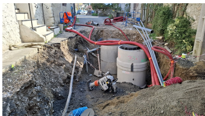
Travaux d'enfouissement des réseaux - rue des Biards
