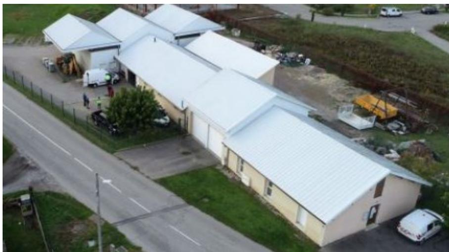
La toiture du centre technique municipal va accueillir 300 m<sup>2</sup> de cellules photovoltaïques pour une production annuelle estimée de 100 000 kWh, grâce à 176 panneaux de 390 Watts.
