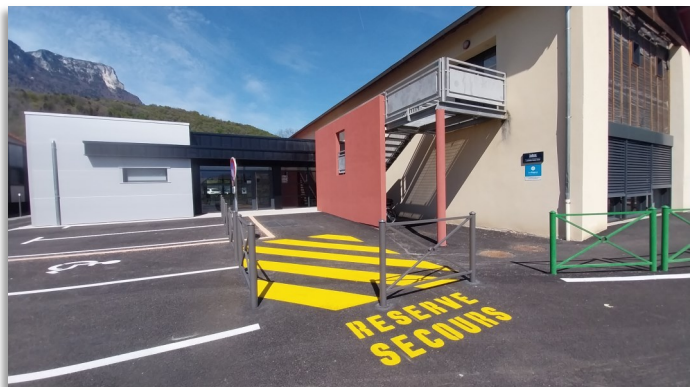
Le nouvel équipement restaurant scolaire / dojo
