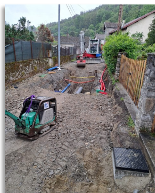
Chemin du Buis - enfouissement réseaux secs et séparatifs
