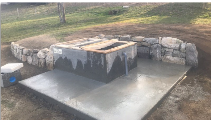
Création d'une dalle et de murets en pierres séchées aux jardins partagés
