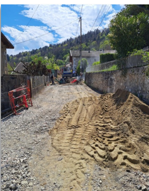
Chemin du Buis - enfouissement réseaux secs et séparatifs
