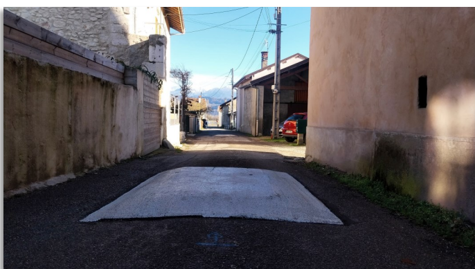
Mise en place de 3 coussins berlinois, rue de l'Etraz de Bise
