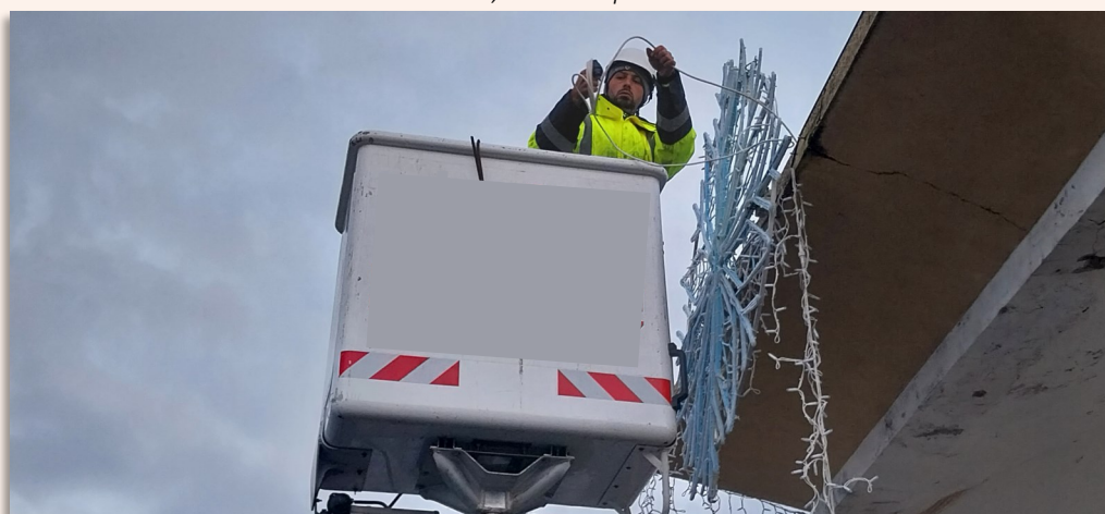
Installation des illuminations par les services techniques
