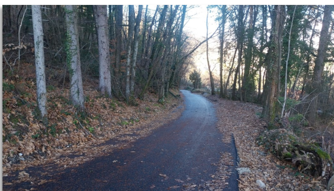
Enrobé sur une partie du chemin d'accès à la Microcentrale
