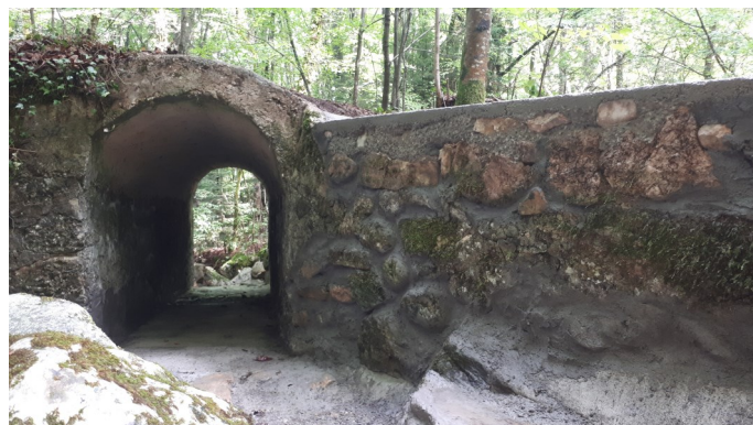
Restauration du pont aux Atrus sur le ruisseau des Eparres
