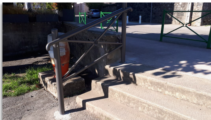
Rampe d'accessibilité place de la mairie
