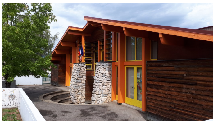
Réfection des peintures des boiseries à l'école maternelle
