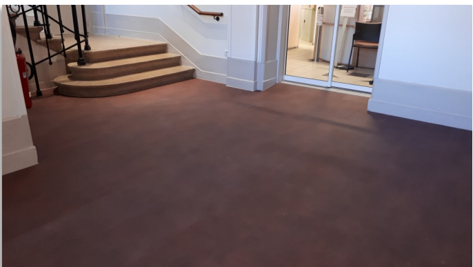
Réfection du sol dans le hall de la mairie
