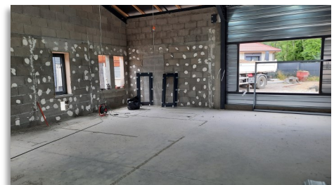
Pose des menuiseries extérieures
