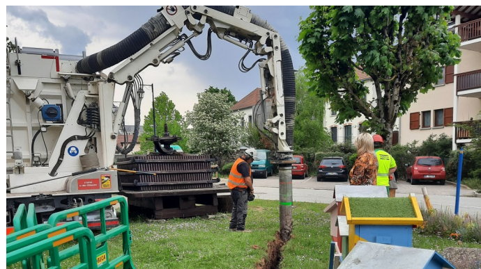
Enfouissement des câbles pour la vidéoprotection, rue de l'Épinette
