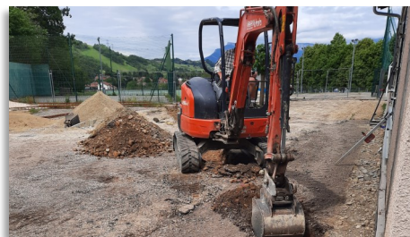
Préparation du muret de la cour
