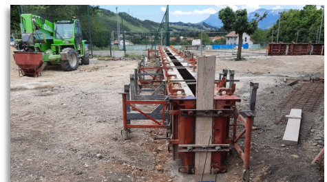
Coffrage du muret
