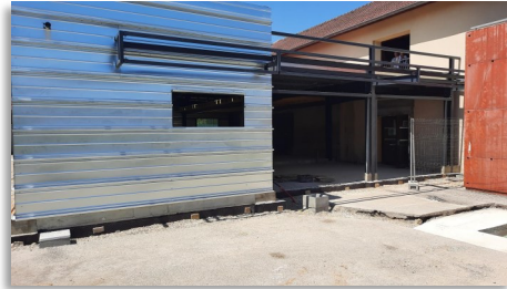
Pose du bardage côté stade
