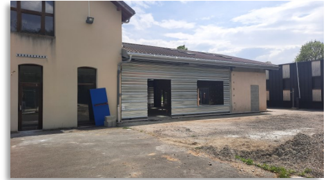
Pose du bardage côté Parc
