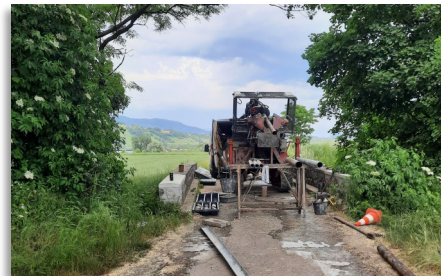
Reconnaissance géotechnique du pont de la plaine dans le cadre du projet de restauration de la continuité écologique sur le Cernon
