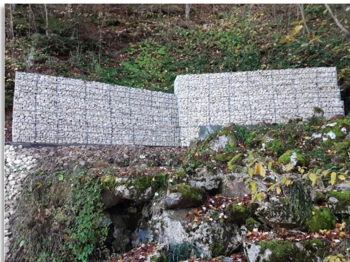
Vue du gabion depuis le captage
