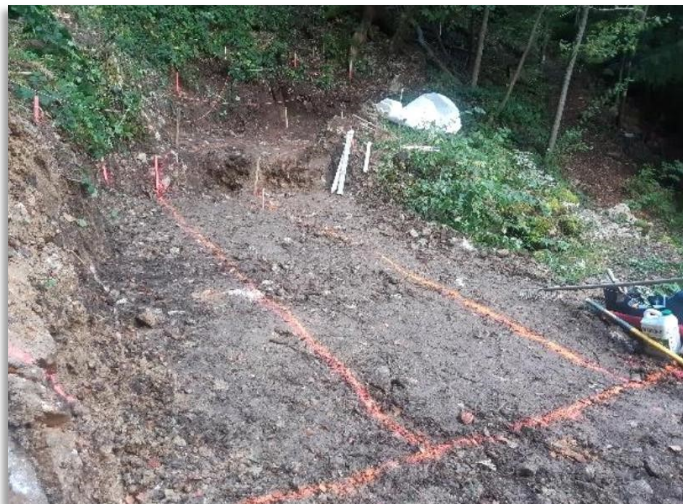
Préparation du terrassement avant la mise en place d'une membrane étanche et du coulage du béton
