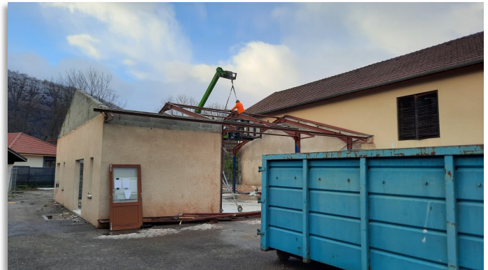
Démontage de la toiture du dojo
