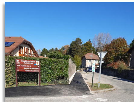
Enrobé sur le trottoir, rue de Clessant
