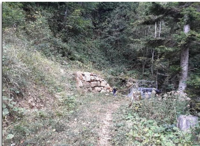
Photo avant le démarrage des travaux
