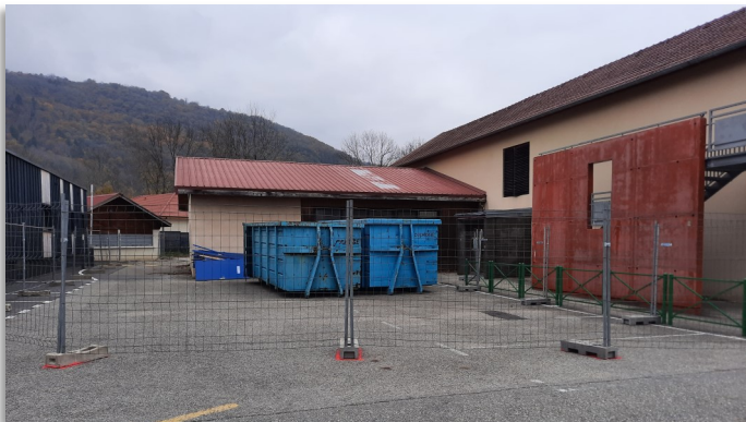
1 er jour du démarrage des travaux
