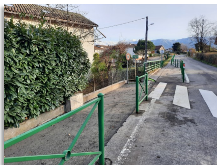
Reprise du muret de soutènement, rue du Souvenir Français
