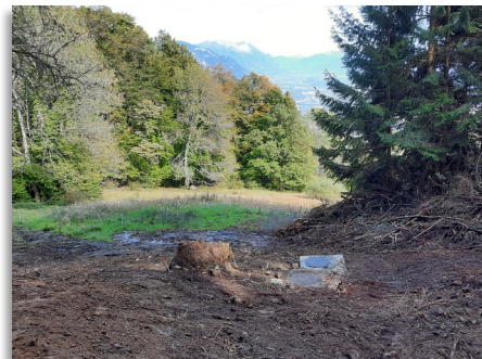
Travaux sur le captage de Saint-Marcel-d'en-Bas
