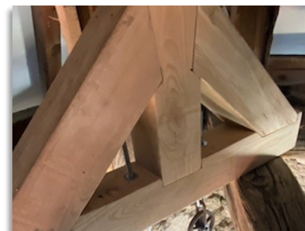
Réfection du clocher de l'église de Bellecombe
