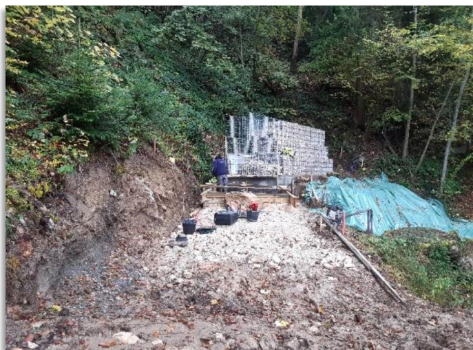
1 er tronçon des gabions terminé
