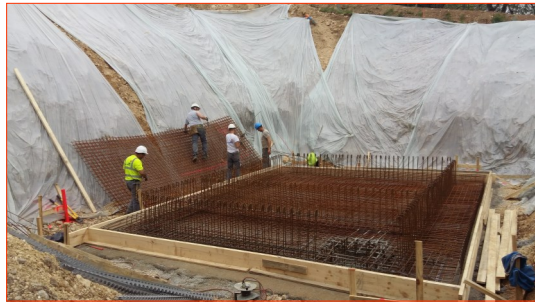
21 avril 2016 - Ferrailage du rez-de-chaussée de la microcentrale du Villard
