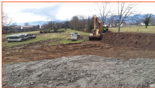
11 janvier 2016 - Démarrage des travaux
