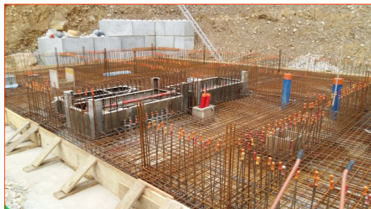
6 juin 2016 - Coffrage du canal de sortie au Villard
