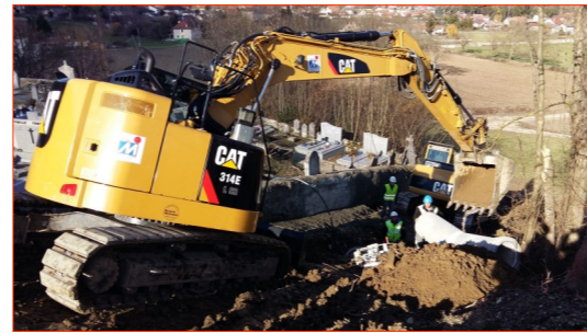
19 février 2016 - Pose des tuyaux béton Ø500 le long du cimetière de la Cura
