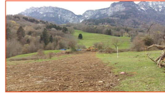
29 mars 2016 - Remise en forme après enfouissement de la conduite d'eau potable
