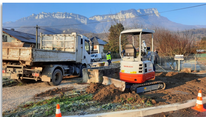
Engazonnement au niveau de la fontaine
