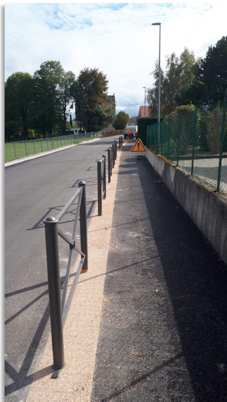
Pose de barrières, Avenue du Granier
