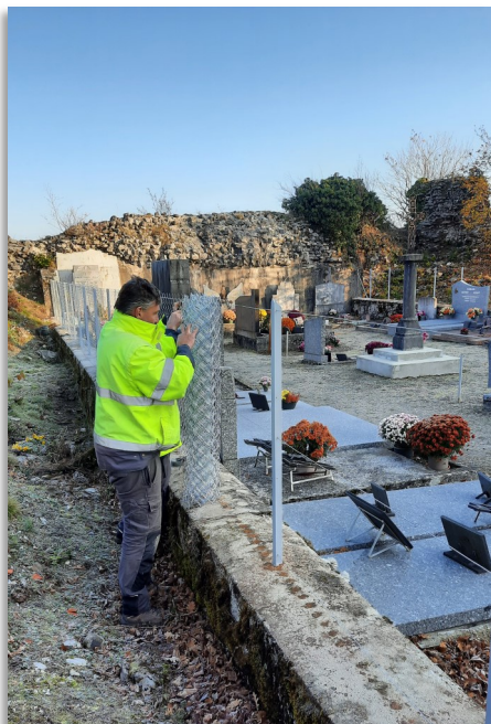
Pose du grillage au cimetière de Bellecombe
