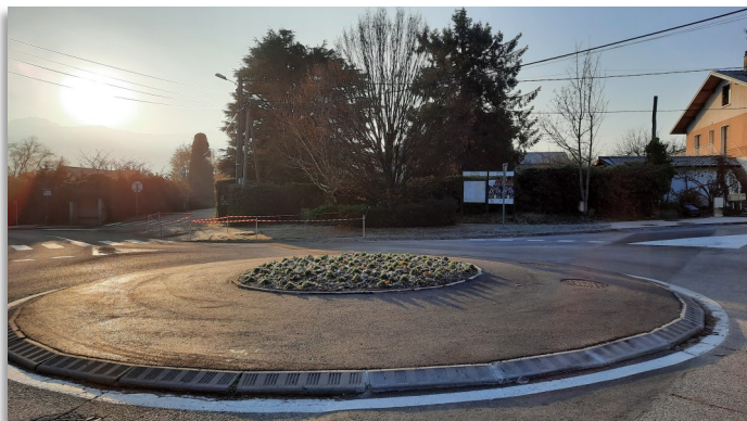
Réfection du rond-point
