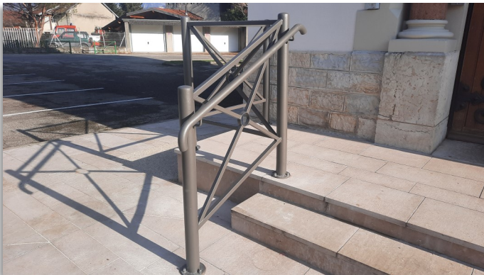
Pose d'une rampe à la mairie
