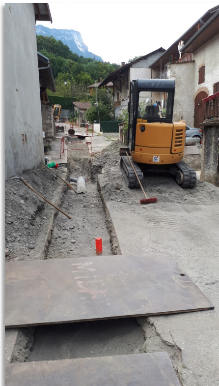
Changement du tuyau eaux pluviales, allée de Payot
