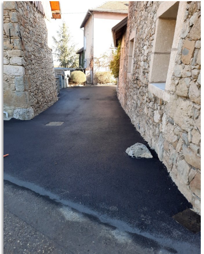
Enrobé, rue des désertes à la Palud
