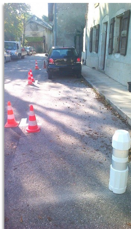
Création de 2 places de parking et pose d'un potelet, rue des Girards
