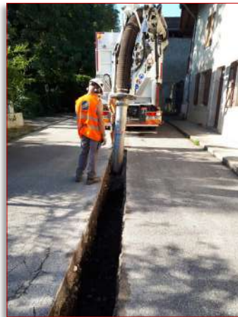
Travaux d'enfouissement de la ligne haute tension aux Girards
