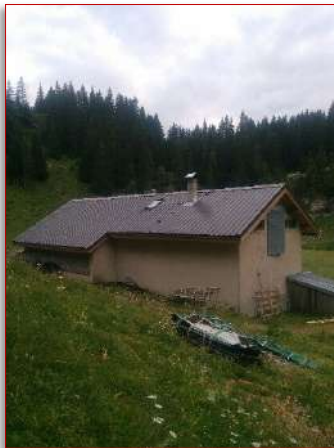
Toiture neuve sur le chalet de l'Alpette
