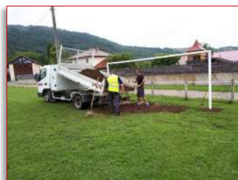
Remise en état des cages de foot
