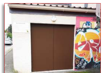
Nouvelle porte pour le matériel de la salle polyvalente
