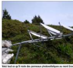
PARIS DELAY Vide tout ce qu'il reste des panneaux photovoltaïques au mont Granier.
