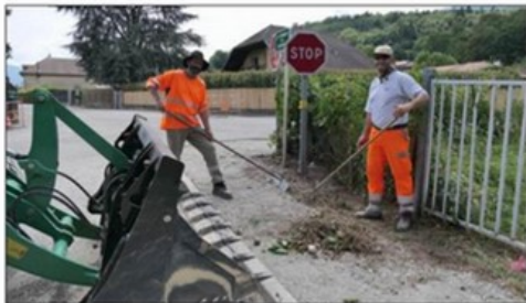
Benoît, Ahmed et Fayçal se sont occupés des finitions du cheminement piétons et cyclistes.
