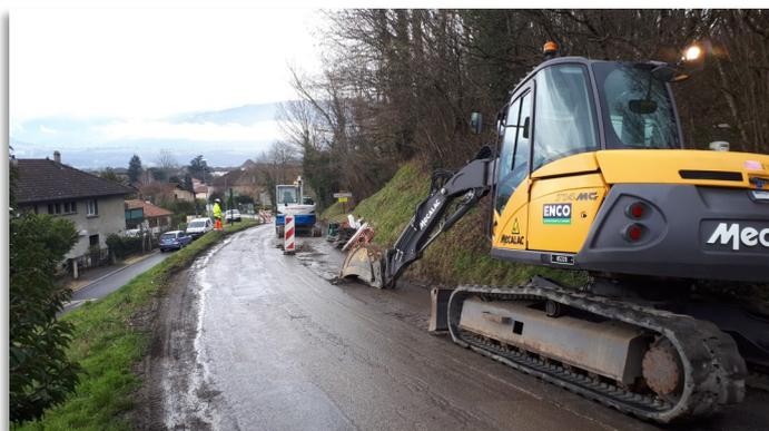
*Remplacement de la conduite d'eau potable, Route de Chartreuse*
