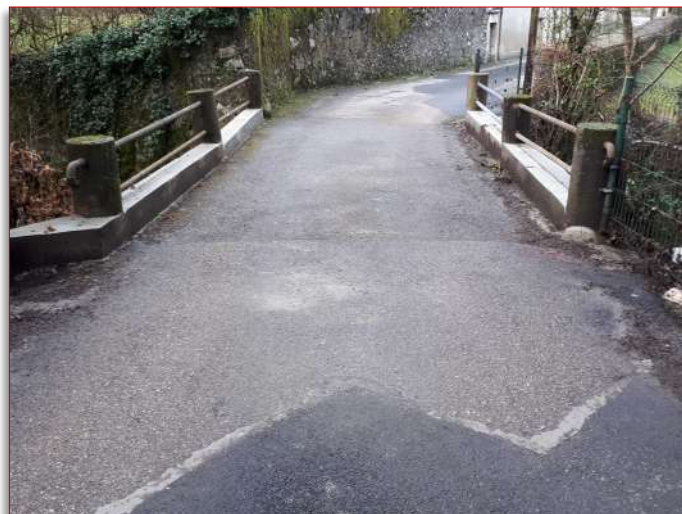
Renforcement du parapet du Pont des Muriers
