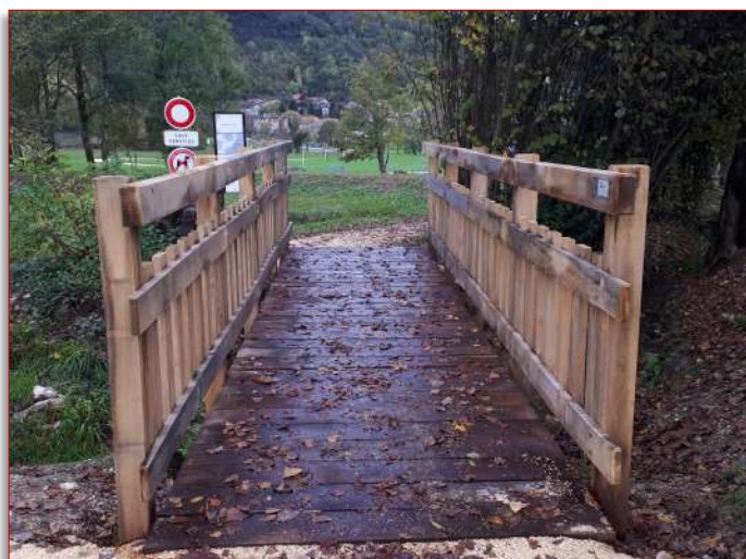
Pose d'une passerelle entre le chemin du Rivasson et le Parc du Granier
