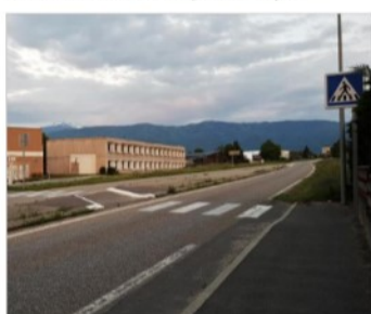
C'est là que Johan Blanc a été percuté par la moto le 22 avril dernier. Et c'est ce passage que le Département va supprimer. Photo Le DL/E.D.
