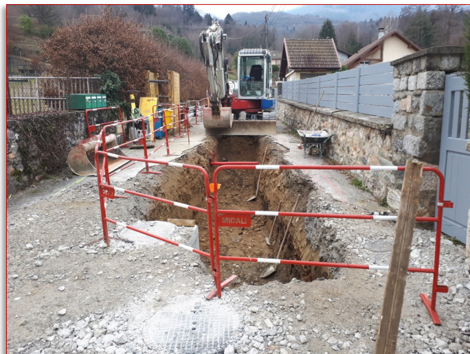
Travaux rue Saint Roch : eau potable et mise en séparatif
