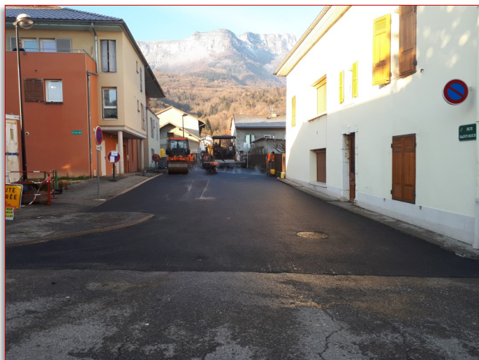
Travaux d'enrobé, rue Saint Roch
