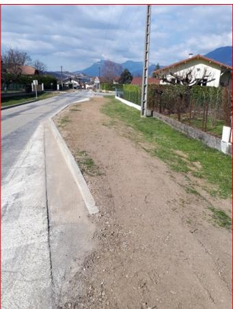
Reprise des gazons après le passage de la fibre optique sur la route de Barraux
