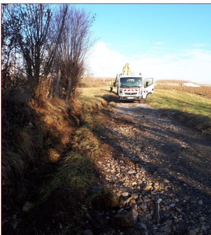
Curage des rigoles et fossés au bord des chemins, après les intempéries
