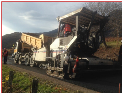
Travaux d'enrobage de la route de la Chartreuse (montée de la Palud)
