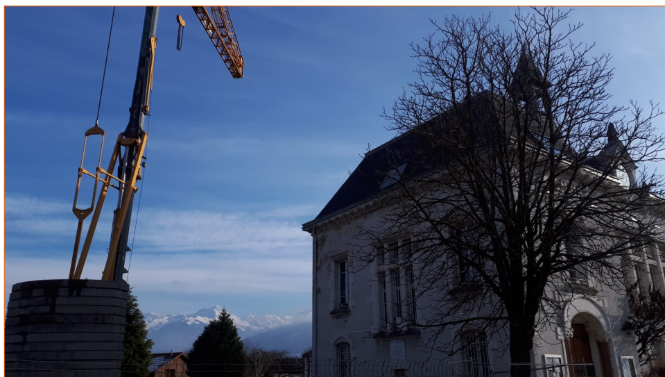
Démarrage des travaux de la caserne des pompiers
