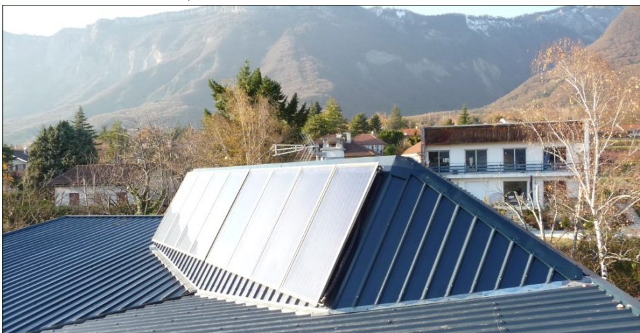
Chantier réalisé par Madisun : pose de capteurs thermiques Green One Tec
