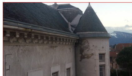
Remise en place de la tôle en zinc sur le toit de la mairie par l'entreprise Uchet
