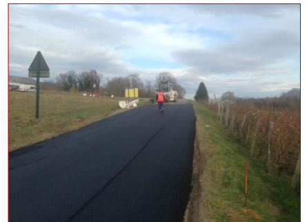
Travaux d'enrobage de la route de la Chartreuse (montée de la Palud)
