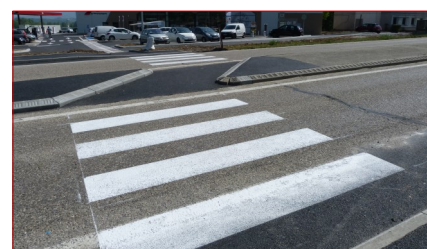
Nouveau passage piéton traversant le terre-plein central de la RD 1090
