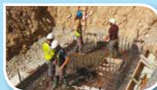
Travaux de la chambre de mise en charge
