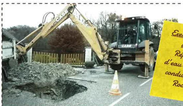
*Exemple d'une intervention d'urgence récente : Réparation d'une fuite d'eau suite à une rupture de conduite. Route des Petites Roches (Les Abrus).*
